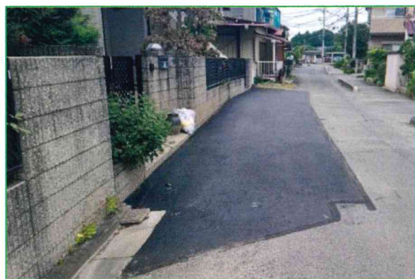
並木地内、未舗装だった道路の舗装を要望しました。
