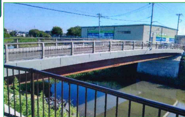
岸町と南古谷を結ぶ新河岸川に架かる昼橋が8月20日に開通しました。
