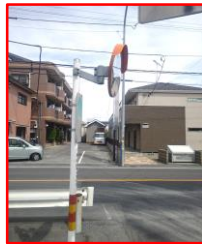
並木地内。住宅開発により見えにくくなったミラーにアジャスター設置
