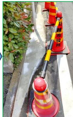
岸町二丁目地内。降雨時に雨水が溜まってしまっていたL字溝の改修。
